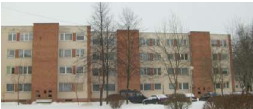
1 pav. Nagrinėjamo reprezentacinio pastato pagrindinis fasadas Picture 1. The main facade of analysed representative multistorey building
