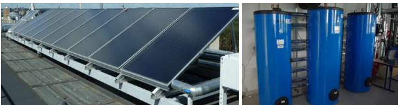
2 pav. Plokščiųjų saulės kolektorių sistema PEMS laboratorijoje Picture 2. The Flat plate solar collectors system of PEMS laboratory
