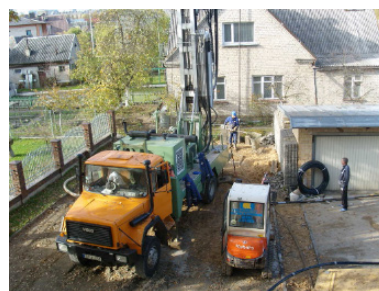
5 pav. Šilumos siurblio gręžinių gręžimo darbai
