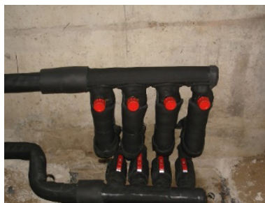
7 pav. Šilumos siurblio gręžinių zondų kolektorius
